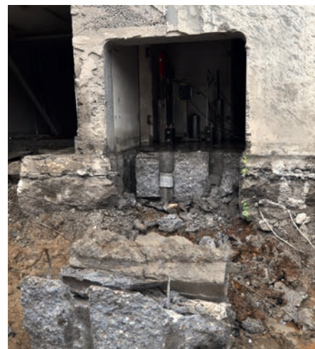
Das Mauerwerk nach erfolgter Trennung.
