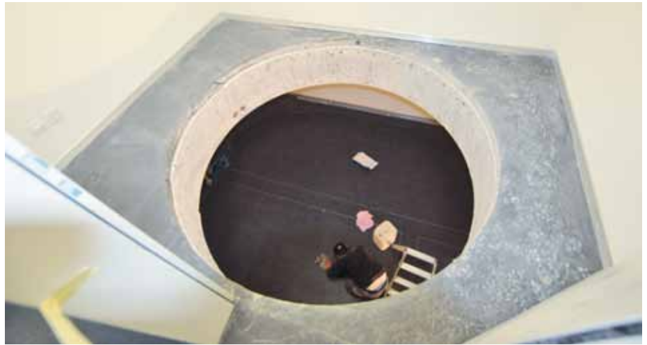
Alles vorbereitet zum Einbau der Wendeltreppe.
