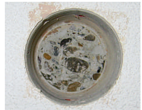
Die ausgeführte Kernbohrung, ohne jegliche Beschädigung der Decke.
