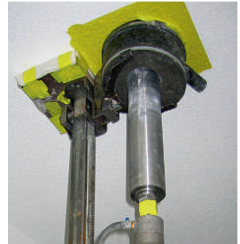
Kernbohrung mit montierter Absaugvorrichtung.
